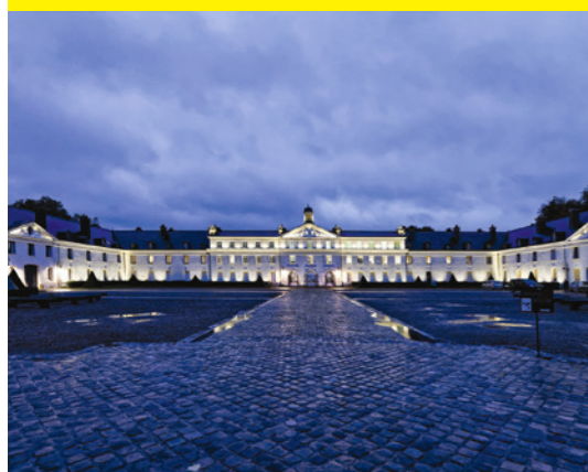
Château de la Verrerie, Le Creusot © R. Douarre
